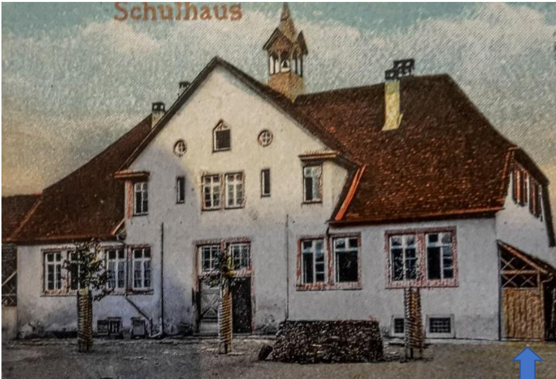
Fertiger Holzschuppen für Löscheräte am Westgiebel (blauer Pfeil) der zum Schulhaus umgebauten Zehntscheuer
