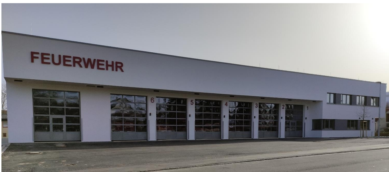
Einzug am 20. Februar 2021 ins neue Feuerwehrhaus
