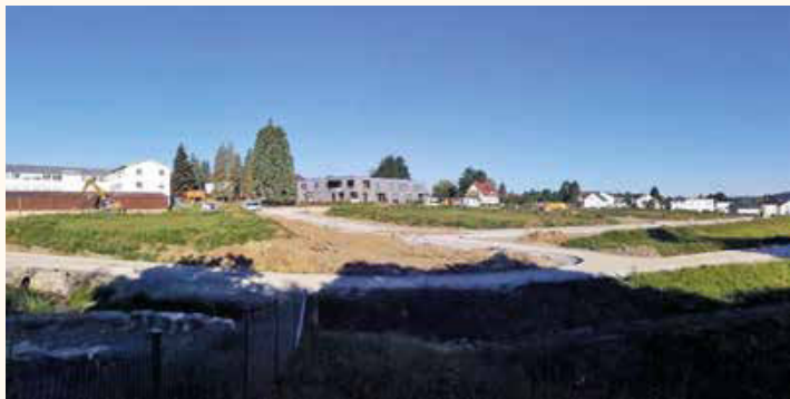
Építési terület Oberwiesen II.
